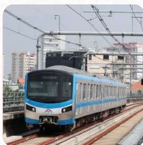
Dự án Metro Bến Thành - Suối Tiên
