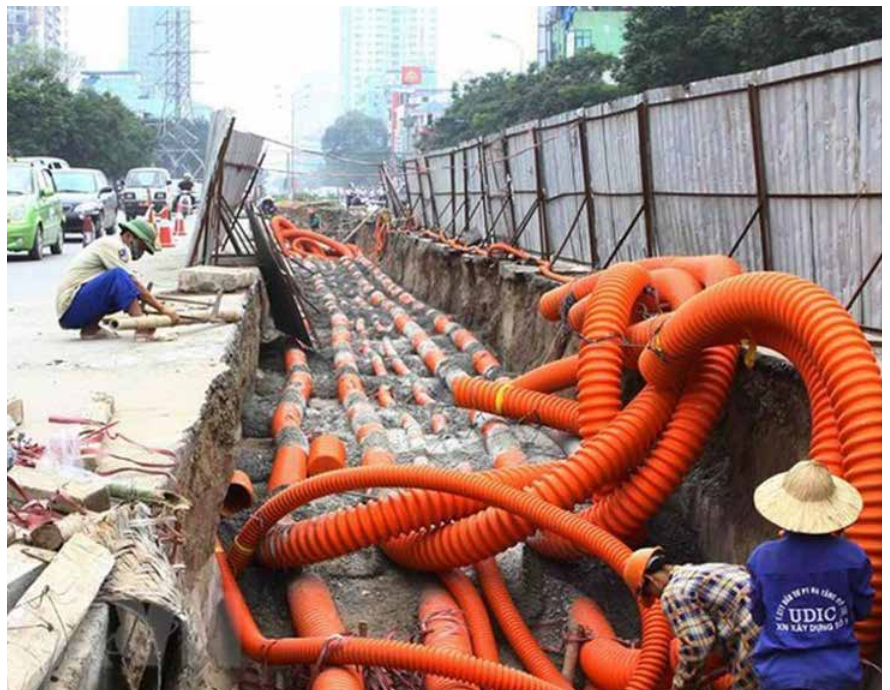
Hình 1. Thi công tuyến cáp ngầm 110 kV tại khu vực trạm biến áp Thanh Xuân, Hà Nội (nguồn: Tạp chí Năng lượng Việt Nam)
