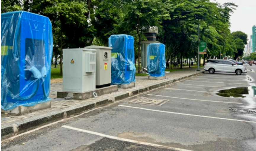
Lắp đặt trụ sạc siêu nhanh cho xe điện trên vỉa hè
