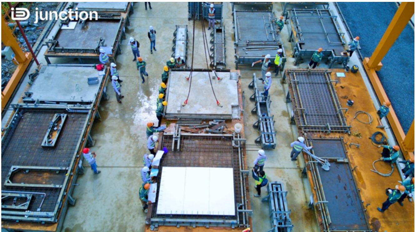
Hình 2. Toàn cảnh tháo khuôn thành phẩm cấu kiện precast tại dự án iD Junction vào tháng 6/2022
