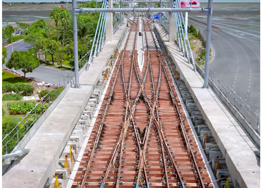
Hình 1. Các dự án hạ tầng giao thông như đường sắt có quy mô lớn, vòng đời dài.
