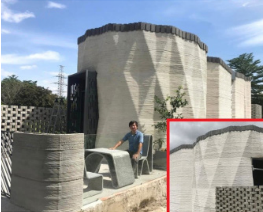
Hình 3. Công trình được in 3D tại TP. Thủ Đức
