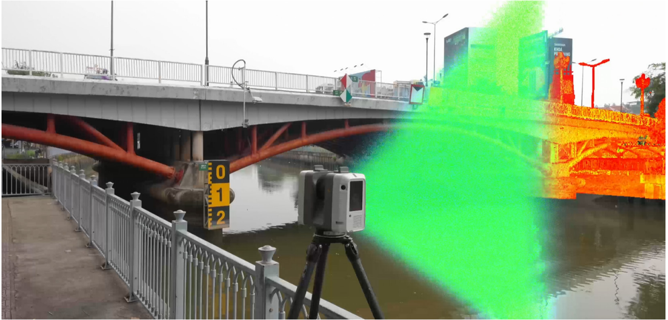
Hình 3. Máy quét 3D laser ghi nhận dữ liệu kết cấu cầu vòm thép.
