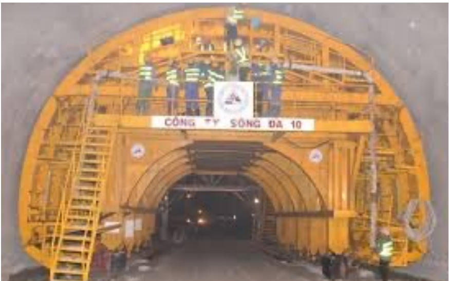
Hình 8 - Thí dụ về hệ ván khuôn định hình thi công vỏ hầm toàn khối
