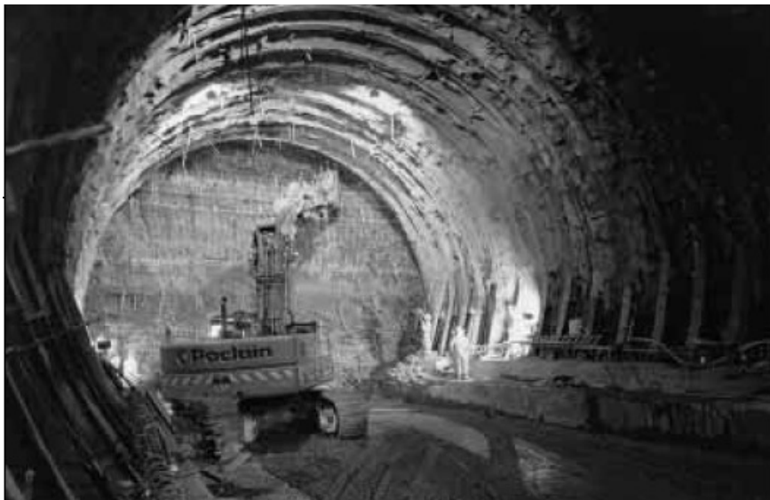
Hình 6 - Một hầm ngang đang được thi công
